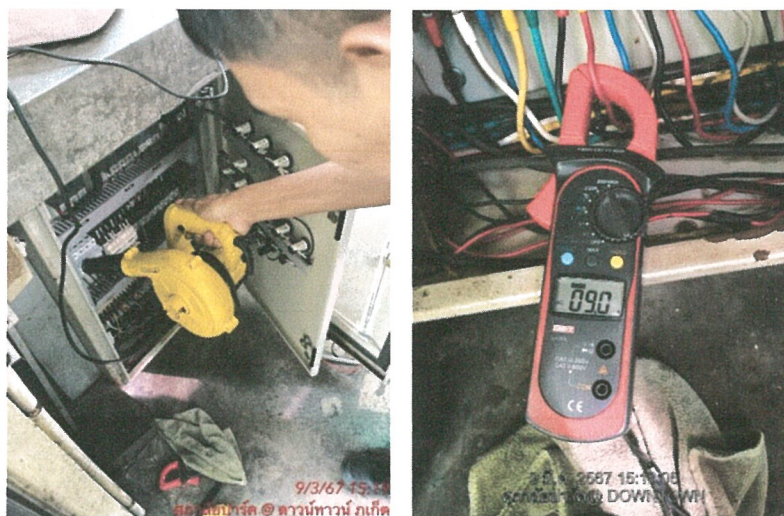
รูปภาพที่ 2.37 การตรวจสอบเครื่องสูบน้ำ
