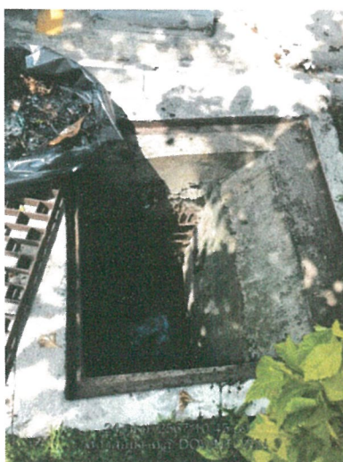
รูปภาพที่ 2.30 การขุดลอกตะกอน
