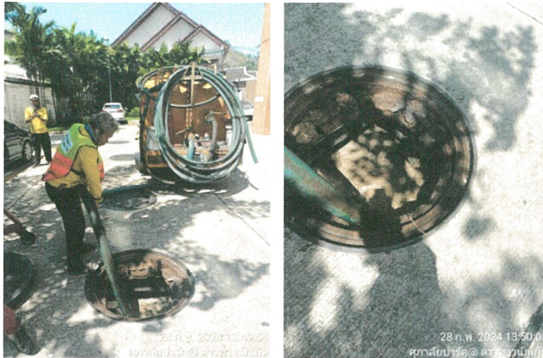
รูปภาพที่ 2.9 การสูบลูบตะกอน
